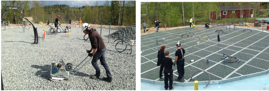
Figur 5: Markplatta av cellglas som ligger i en bädd av återvunnet foamglas. Källa: (Circuitus)
