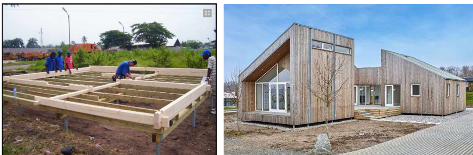
Figur 1: Grundläggning med skruvpålar. Konstruktionsprocess från Alfabryggan (vänster) och det biologiska huset i Danmark (Kebony, 2018) (höger)
