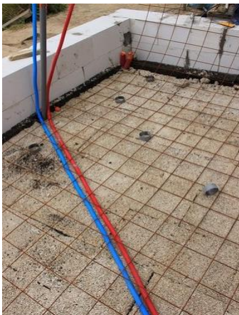
Figur 7: Golvisolering Crupet, Belgien. 2323
