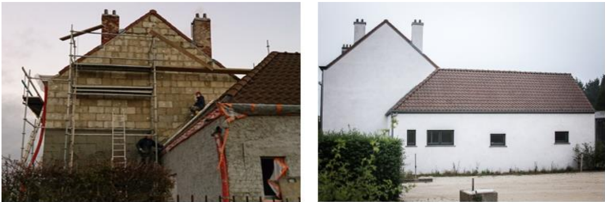
Figur 5: Utvändig renovering - Fristående hus - Limelette Belgien. 2323
