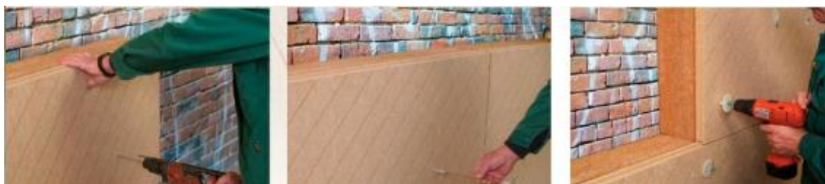
Figur 11: UdiRECO® träfiberisoleringskivor. 32,32
