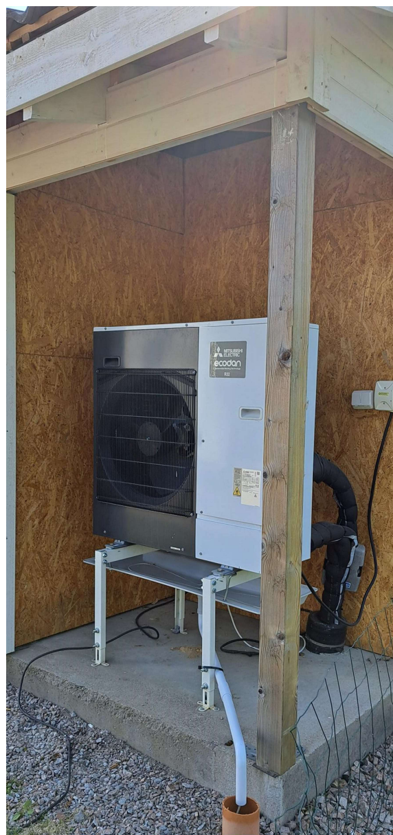
Figur 2: Inomhusdel och utomhusdel (foto taget under byggskedet) för H. Östberg ABs HERU ThermIQ. Foto: H Östberg AB och Fiskarhedenvillan.
