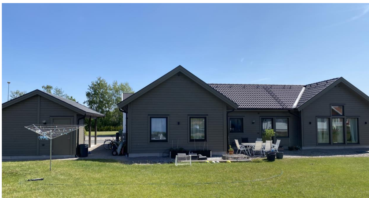
Figur 10: Testhus 4, Trivselhus, uppfört i Kalmar. Foto: Trivselhus.
