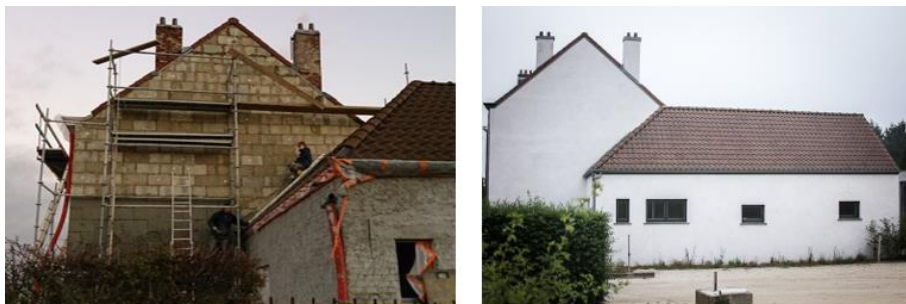
Figur 5: Utvärdig renovering - Fristående hus - Limelette Belgien
