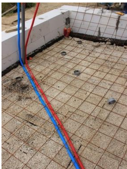
Figur 7: Golvisolering Crupet, Belgien 232323
